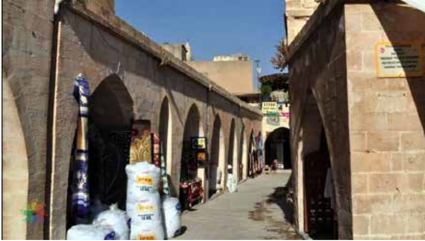
Eski Mardin'de, tarihi çarşıların canlandırılması için bir kısmının restorasyonu gerçekleştirilmiştir.
